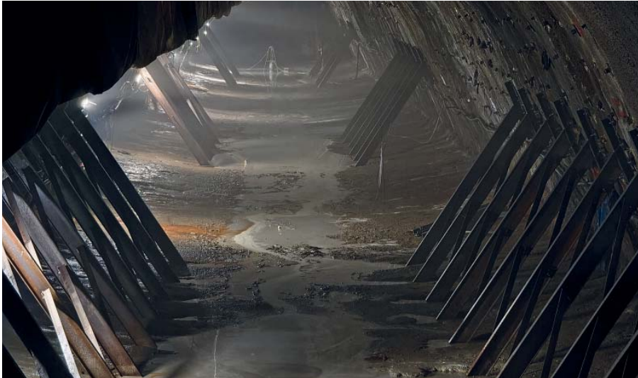
Patní štola staničního tunelu Pankrác
