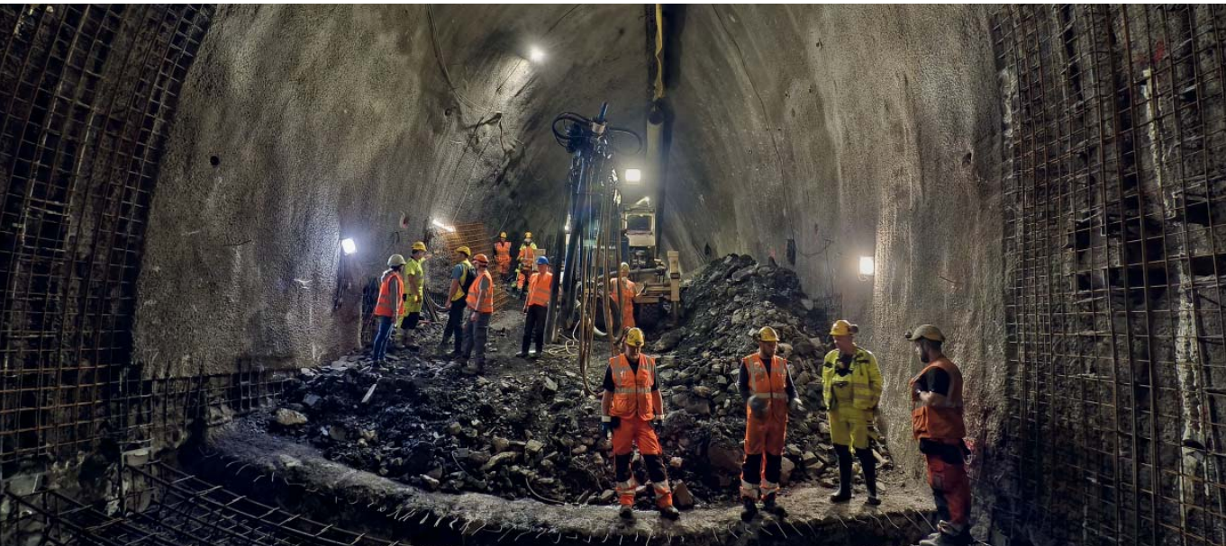
Levý dílčí výrub staničního tunelu Pankrác
