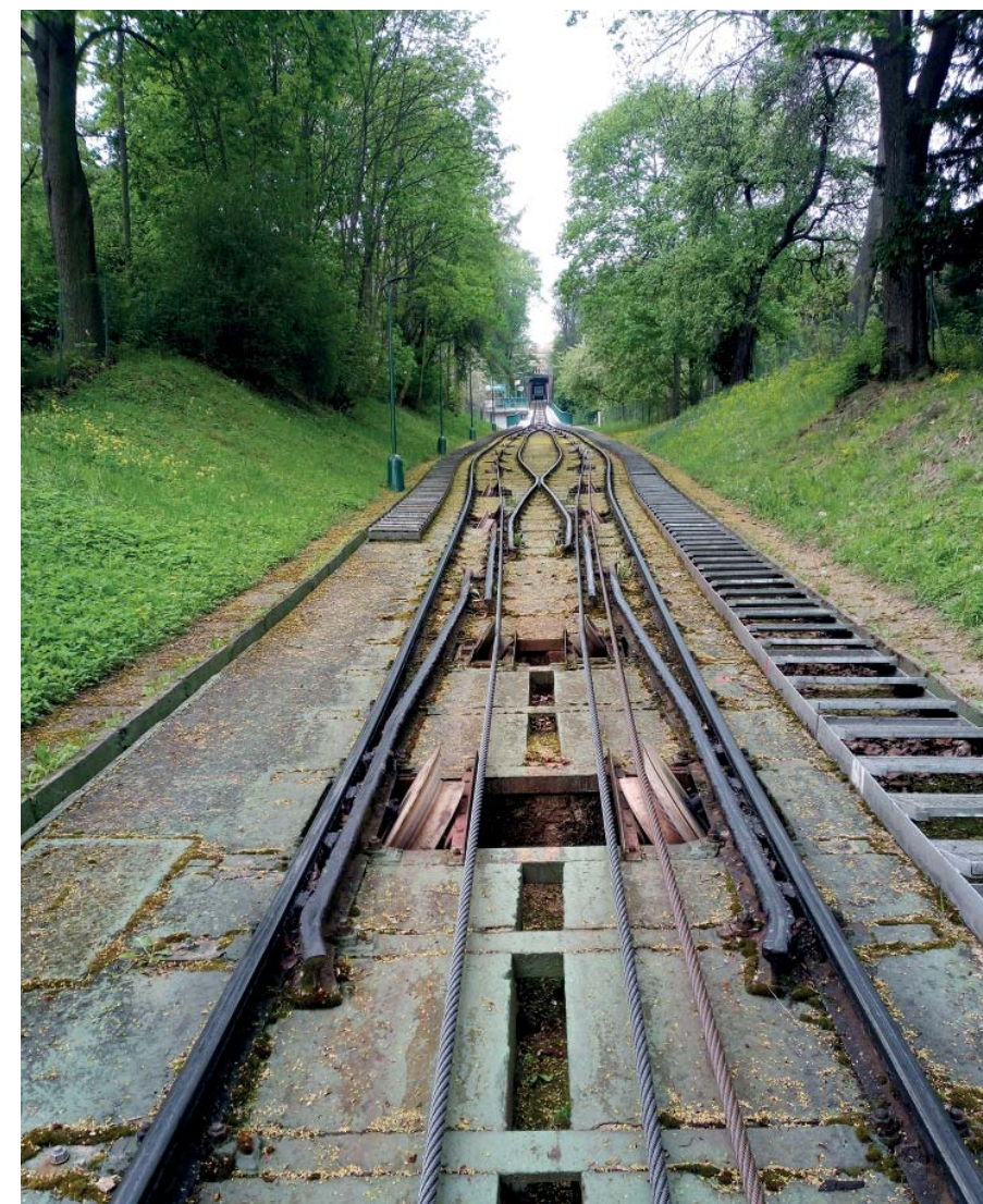
Pohled na stávající řešení Abtovy výhybny
