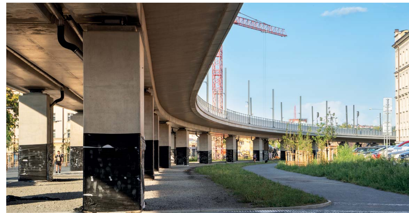
Mostní estakáda podél ulice Strojnické
