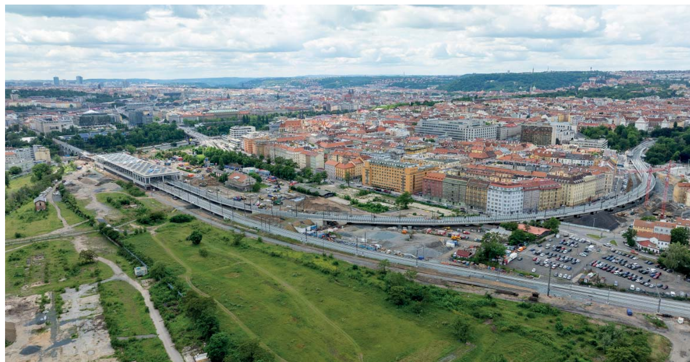
Nadhled celého úseku Bubny - Výstaviště, 06/2025, zdroj: Metrostav TBR
