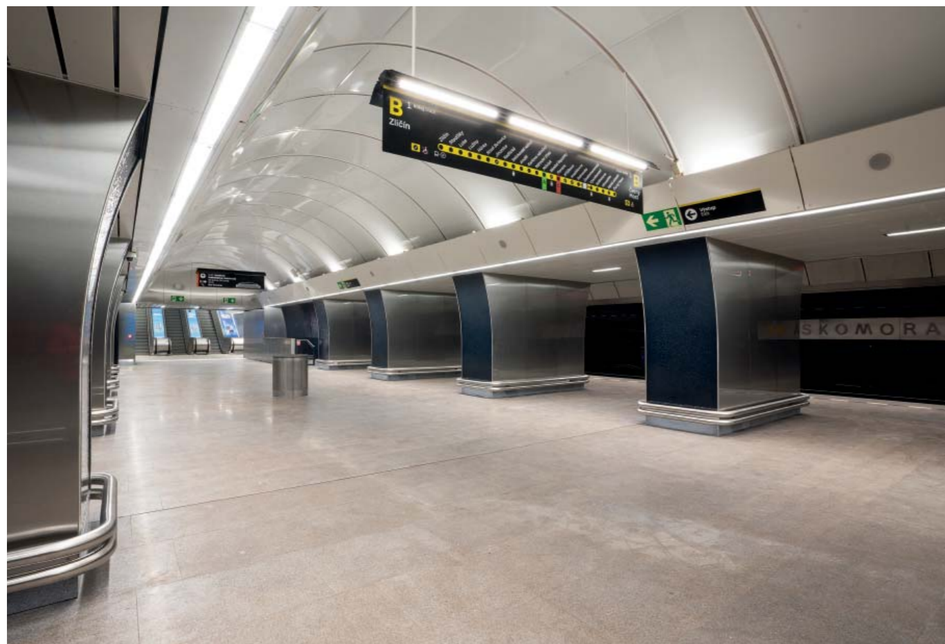
střední loď stanice Českomoravská
