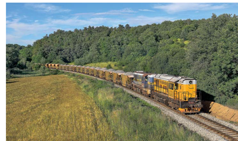
Další pracovní vlak se štěrkem projíždí u Zákolan úsekem Otovice – Brandýsek. Je červen 2024 a výsypné vozy míří na stavbu Modernizace trati Kladno – Kladno-Ostrovec, která bude zanedlouho zprovozněna
