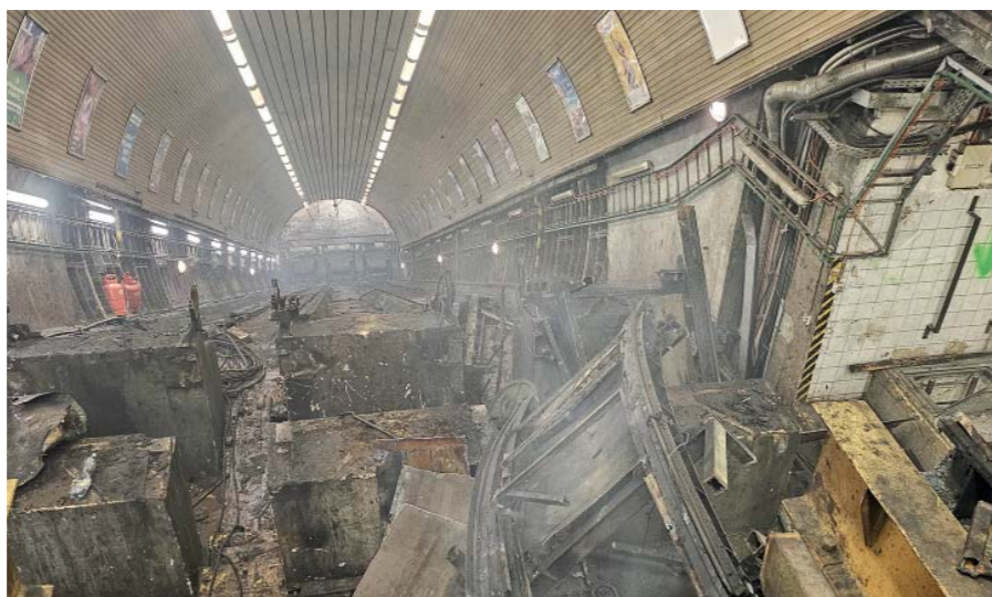
Stanice Flora - rekonstrukce eskalátorového tunelu
