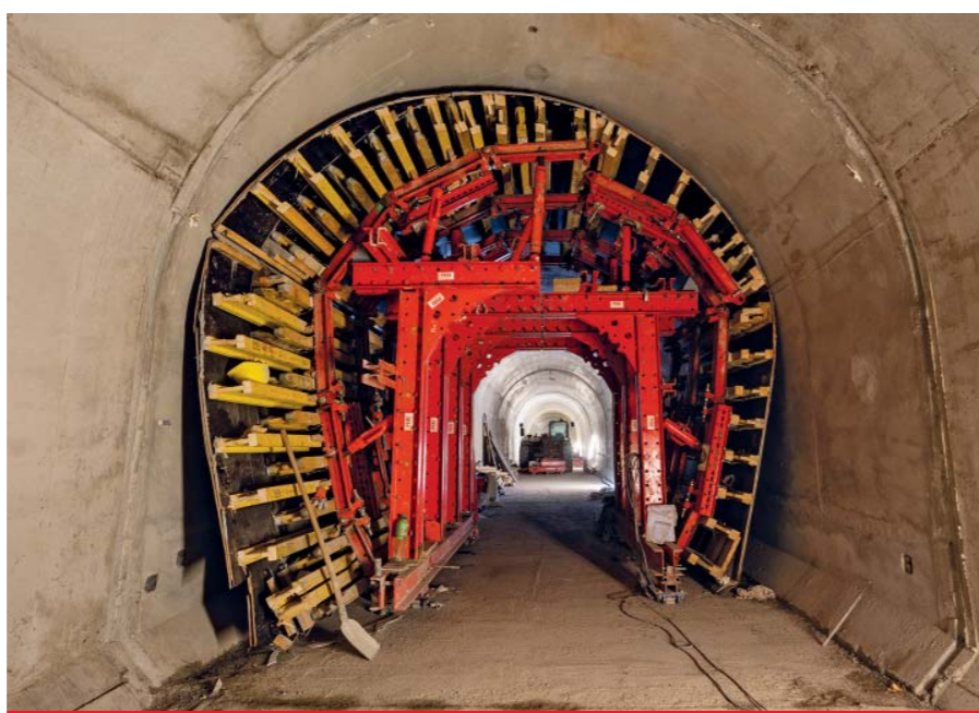
Kolektor Letiště - dokončená část konstrukce
