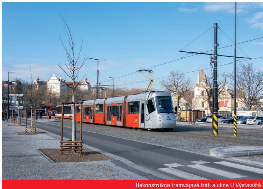
Rekonstrukce tramvajové trati a ulice U Výstaviště
