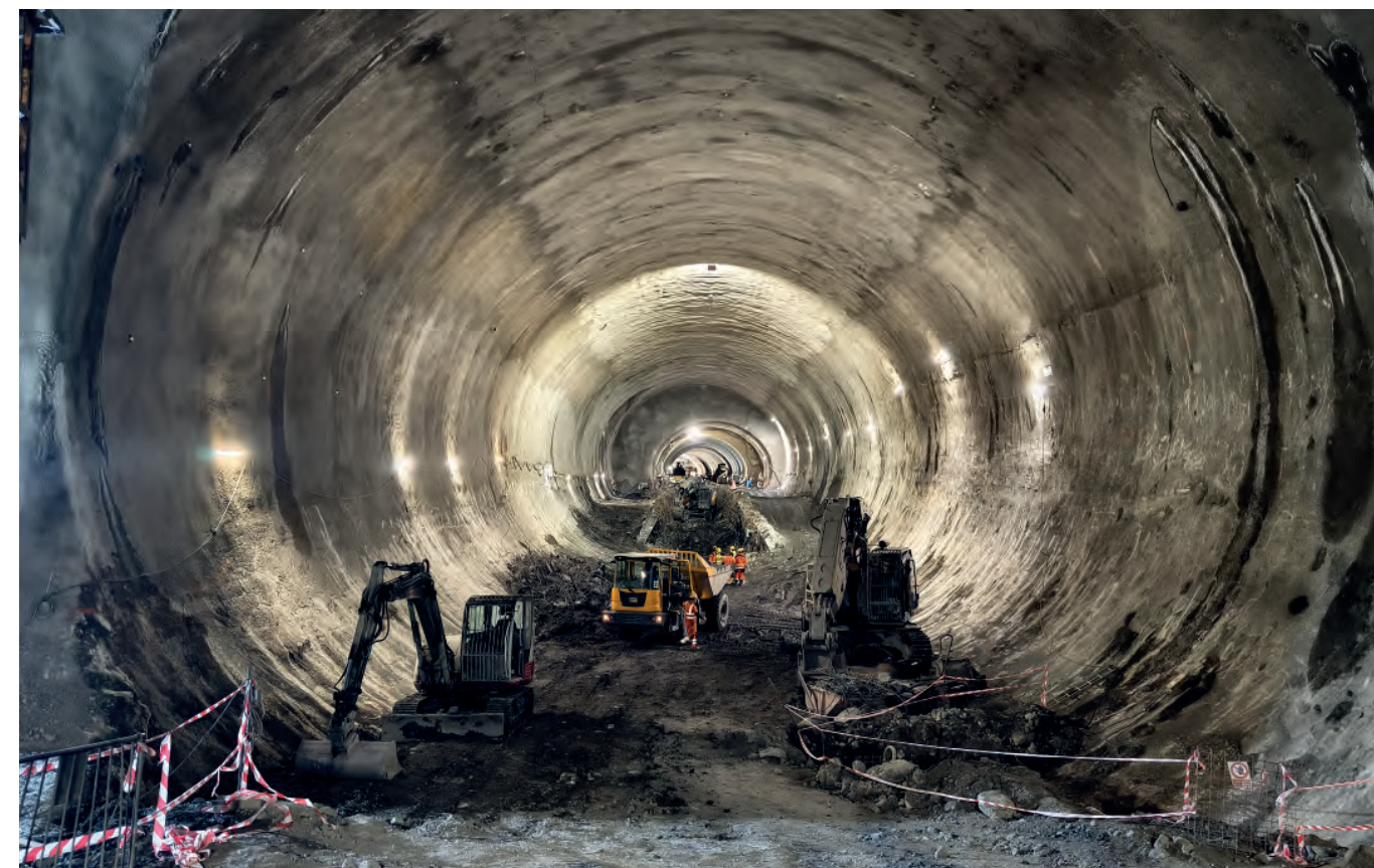
Dokončování ražby staničního tunelu Pankrác D
