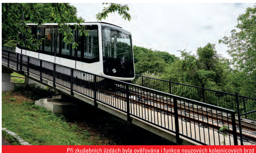
Při zkušebních jízdách byla ověřována i funkce nouzových kolejnicových brzd
