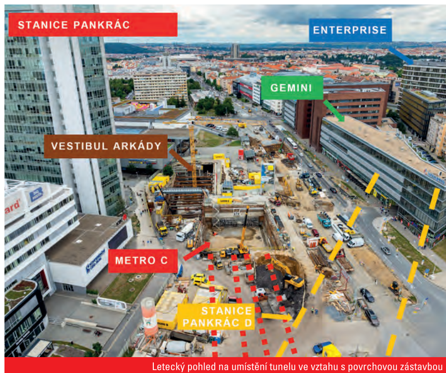
Letecký pohled na umístění tunelu ve vztahu s povrchovou zástavbou
