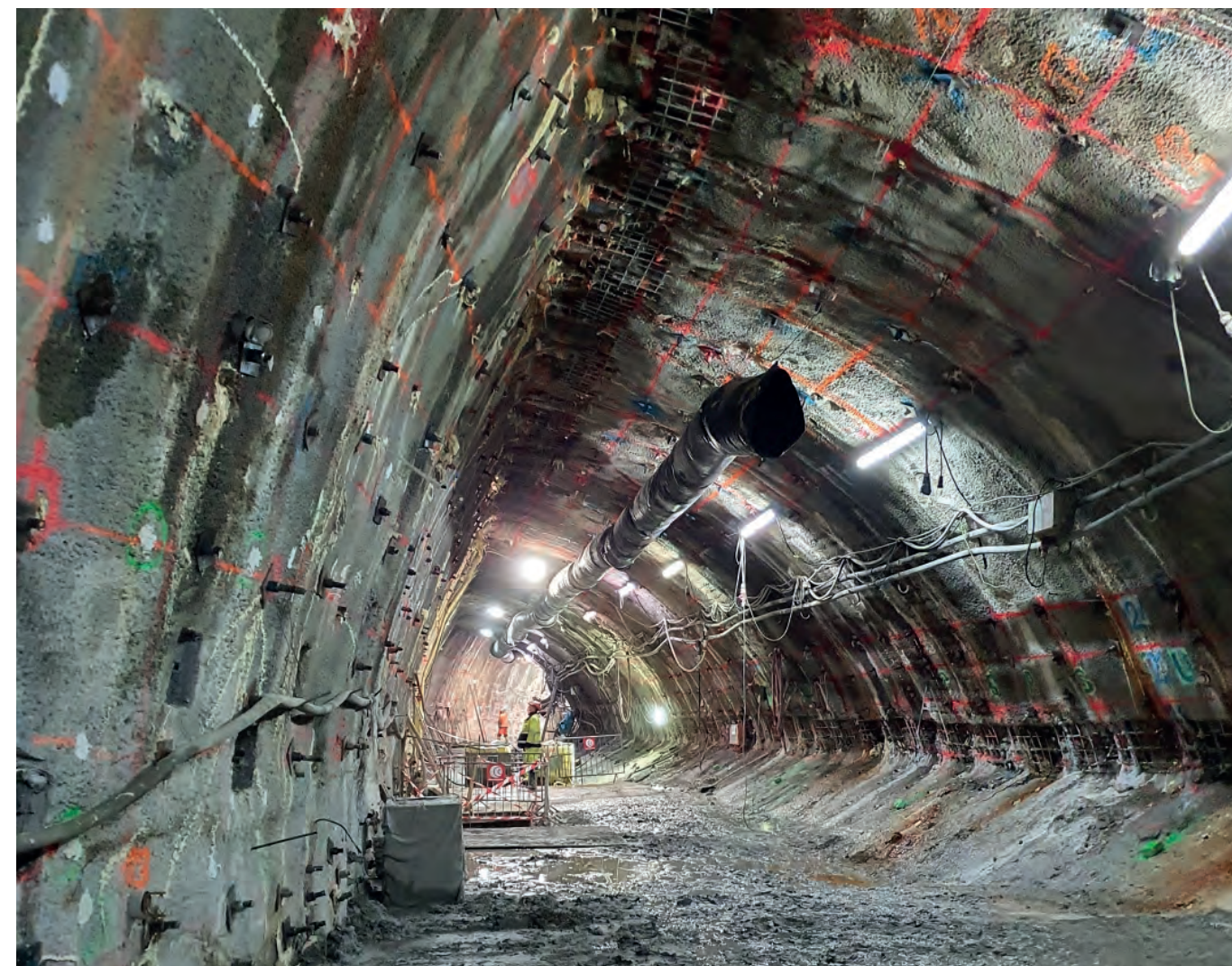
Průzkumná štola s naznačenou polohou injektážních vrtů
