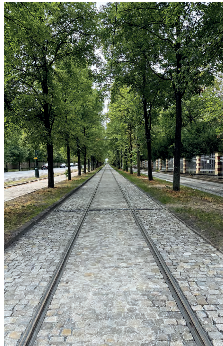
Tramvajová trať v aleji mezi zastávkami Královský letohrádek a Pražský hrad po dokončení prací
