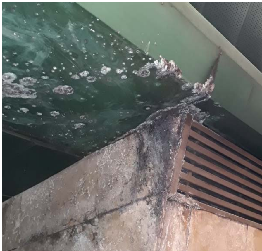
Detail na nástupišti před rekonstrukcí
