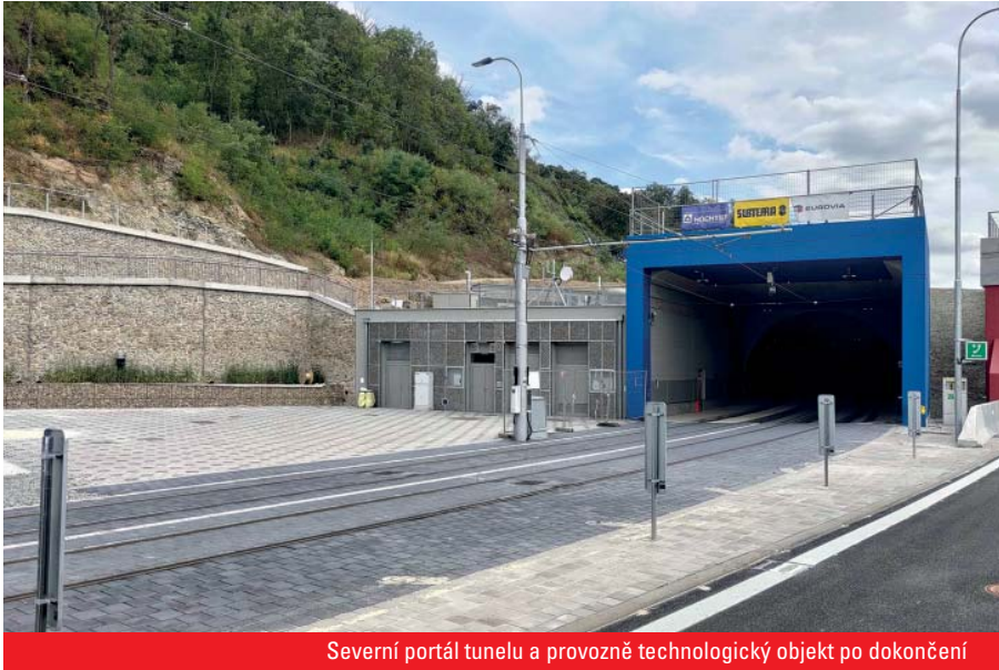
Severní portál tunelu a provozně technologický objekt po dokončení
