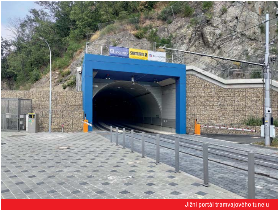
Jižní portál tramvajového tunelu
