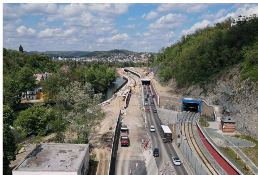
Stavba v realizaci – celkový pohled
