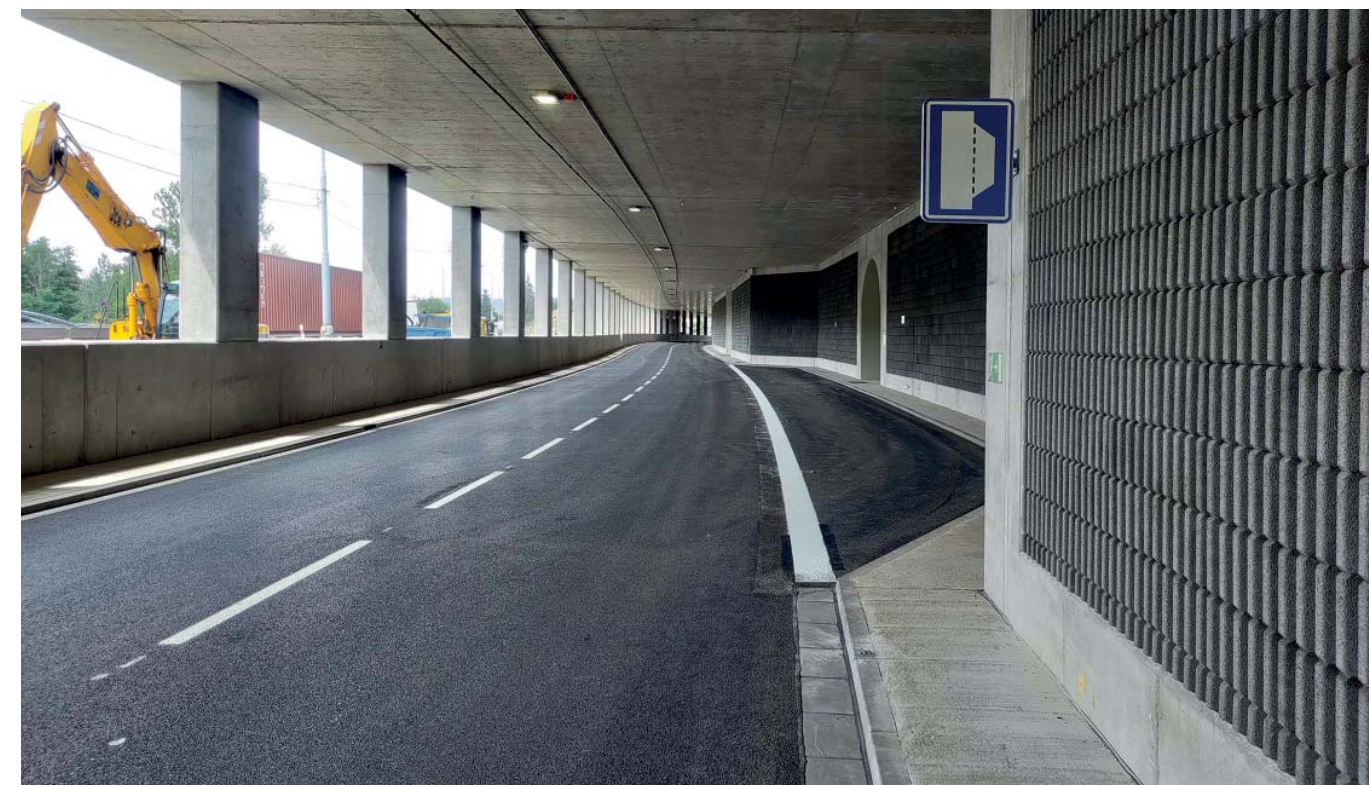
Dokončená silniční galerie
